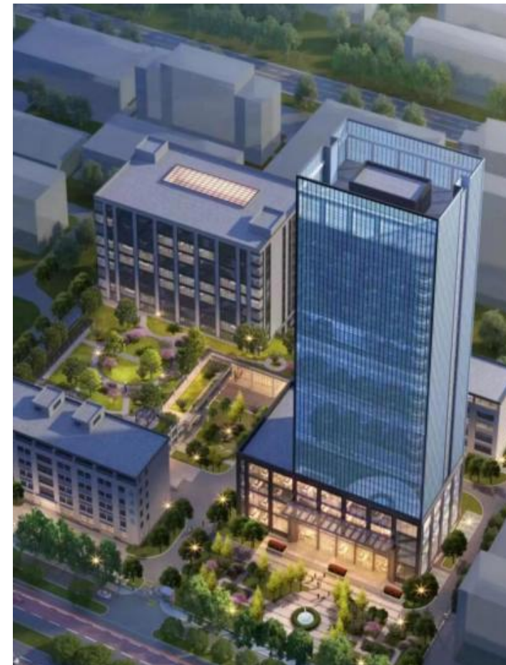
Здание R&D-центра в Сиане (строится)
